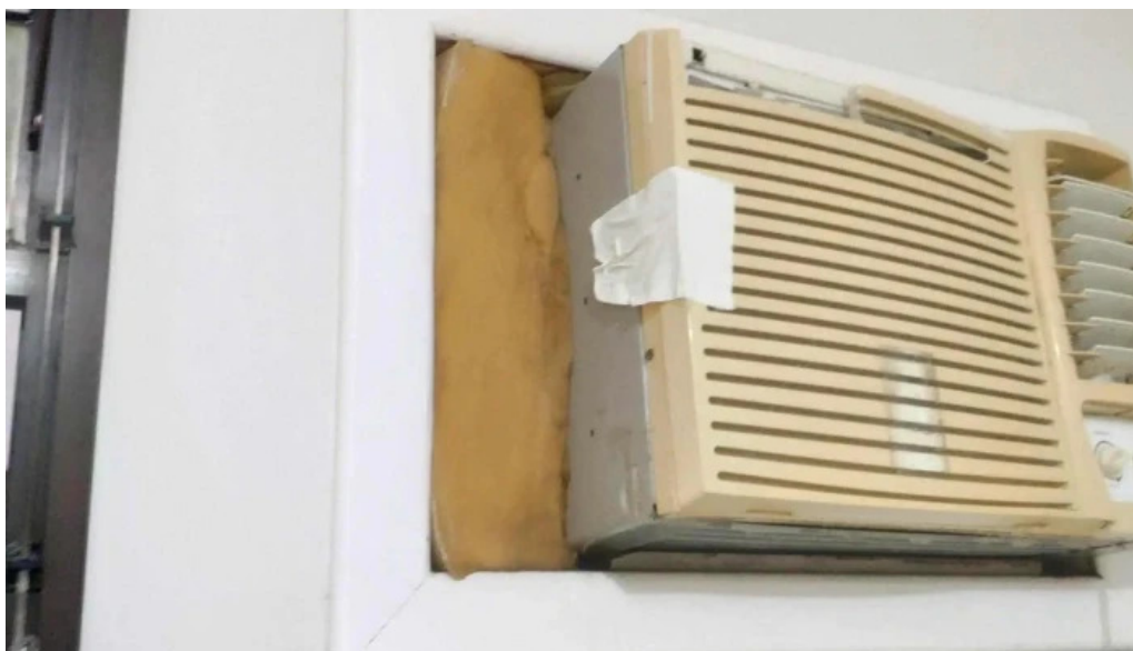
Casa de saude e maternidade santa monica hospital geral
